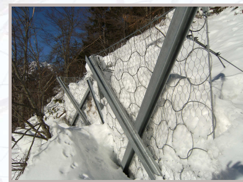
Artigiana Costruzioni s.r.l. – “VELA –Fermaneve”
